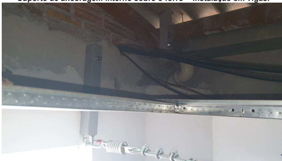
Suporte de ancoragem interno sobre o forro – Instalação em vigas.
