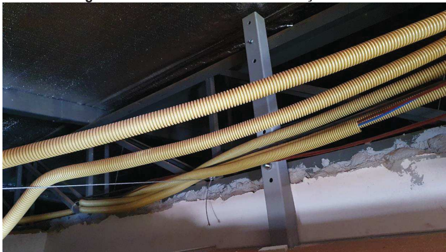
Suporte de ancoragem interno sobre o forro – Instalação na estrutura do telhado.
