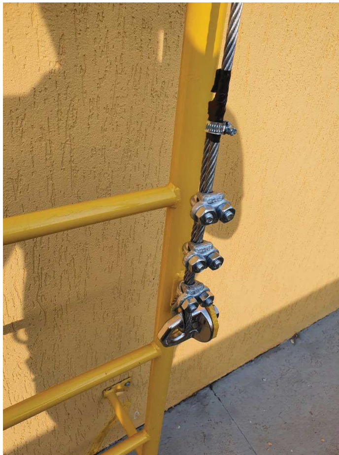
Detalhe linha de vida vertical em escada marinheiro
