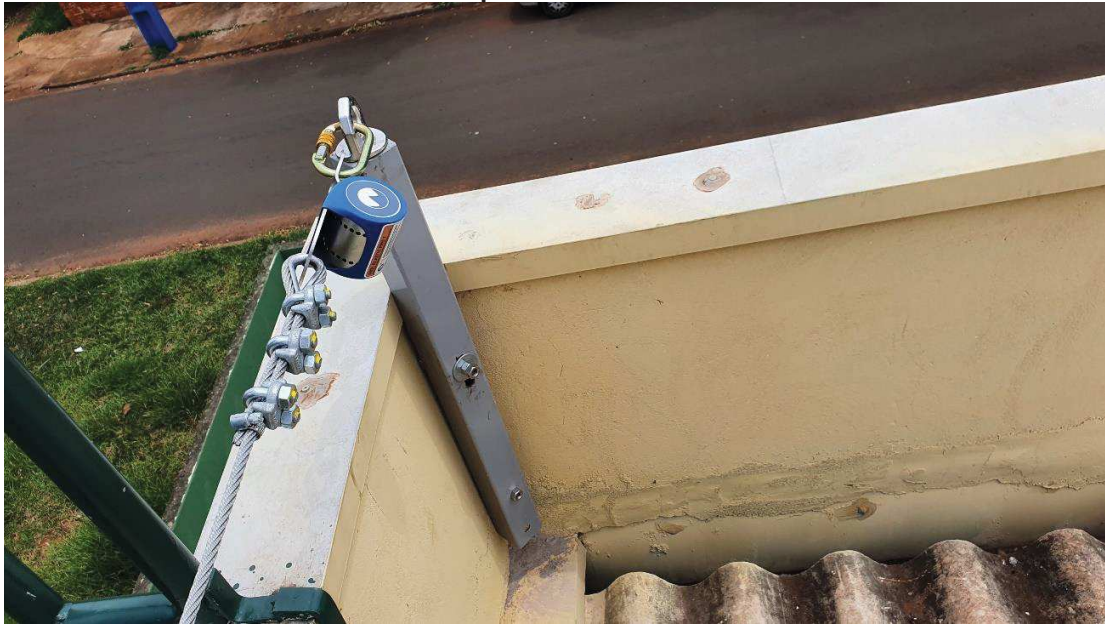
Suporte de ancoragem, com 1 ponto, instalação com fixação química no encontro de platibandas
