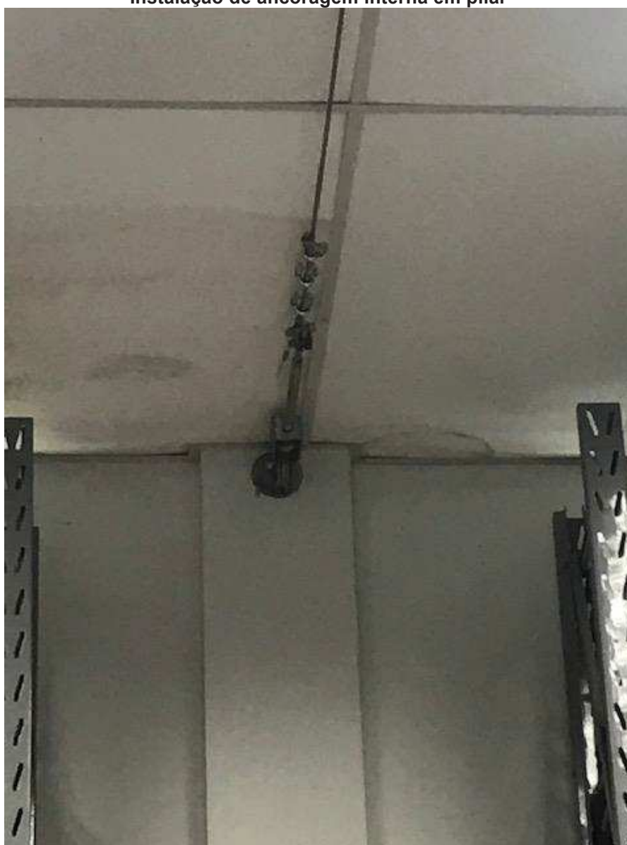
Instalação de ancoragem interna em pilar
